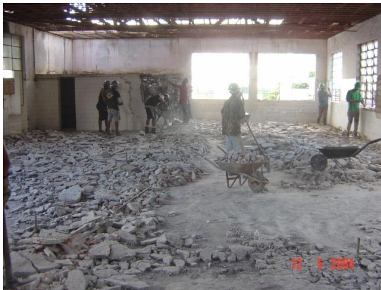
FIGURA 10 - MOINHO MATO-GROSSENSE DE CORUMBÁ, SEGUNDO PAVIMENTO DO PRÉDIO DURANTE REVITALIZAÇÃO
