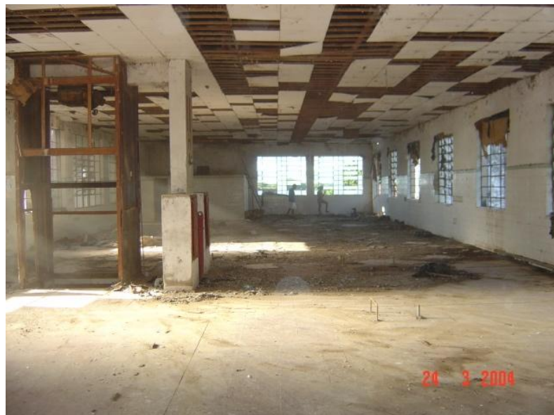
FIGURA 9 - MOINHO MATO-GROSSENSE DE CORUMBÁ, SEGUNDO PAVIMENTO DO PRÉDIO ANTES DA REVITALIZAÇÃO
