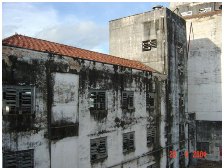
FIGURA 7 - MOINHO MATO-GROSSENSE DE CORUMBÁ, FACHADA INTERNA DO PRÉDIO ANTES DA REVITALIZAÇÃO
