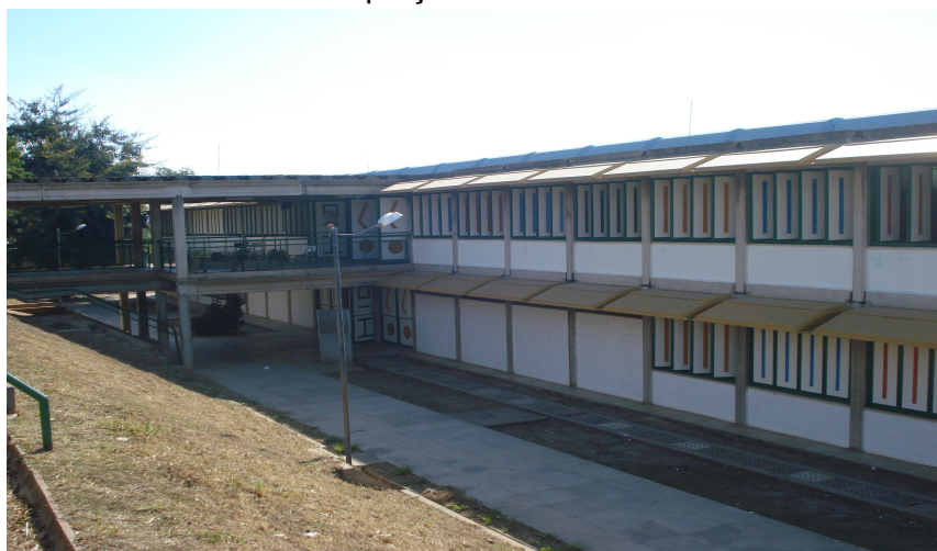
Figura 10: Centro de Atendimento Integral à Criança (CAIC) Padre Ernesto Sassida – prédio onde estão instaladas as salas do ensino fundamental. Fonte: Morais (2009)
