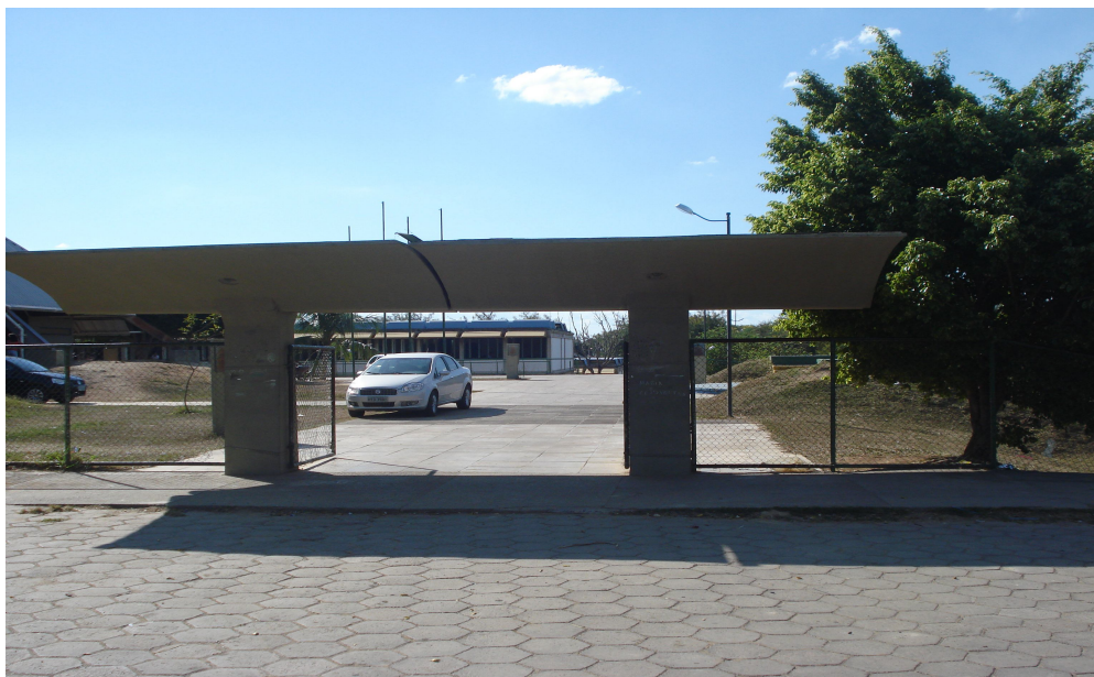
Figura 8: Centro de Atendimento Integral à Criança (CAIC) Padre Ernesto Sassida – entrada principal pela Rodovia Ramon Gomez Fonte: Morais (2009)
